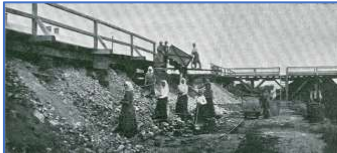
Ručné triedenie a nakladanie železnej rudy na nákladisku (podľa EISELE 1907)
