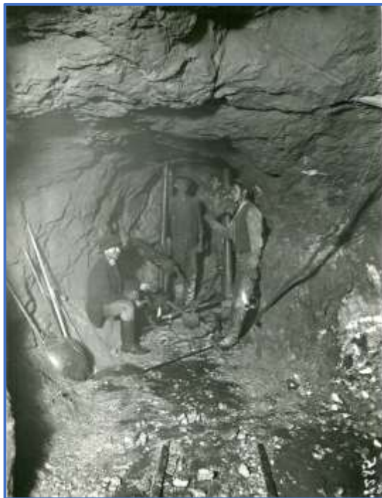
Razenie v rožňavských baniach používaním vŕtacieho stroja okolo roku 1905 (EISELE 1907)
